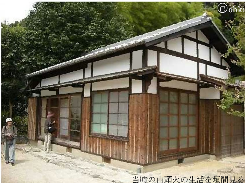
新設された休憩所
